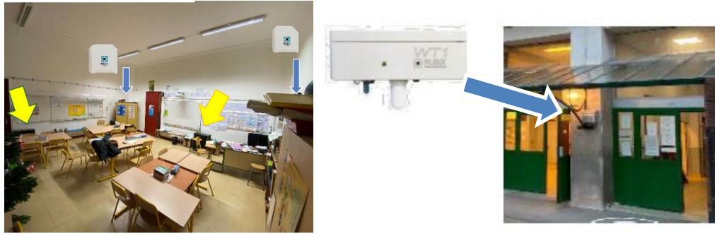
Figure 3 : positionnement des micro-capteurs (flèches bleues) et des deux épurateurs CC800 (flèches jaune)
